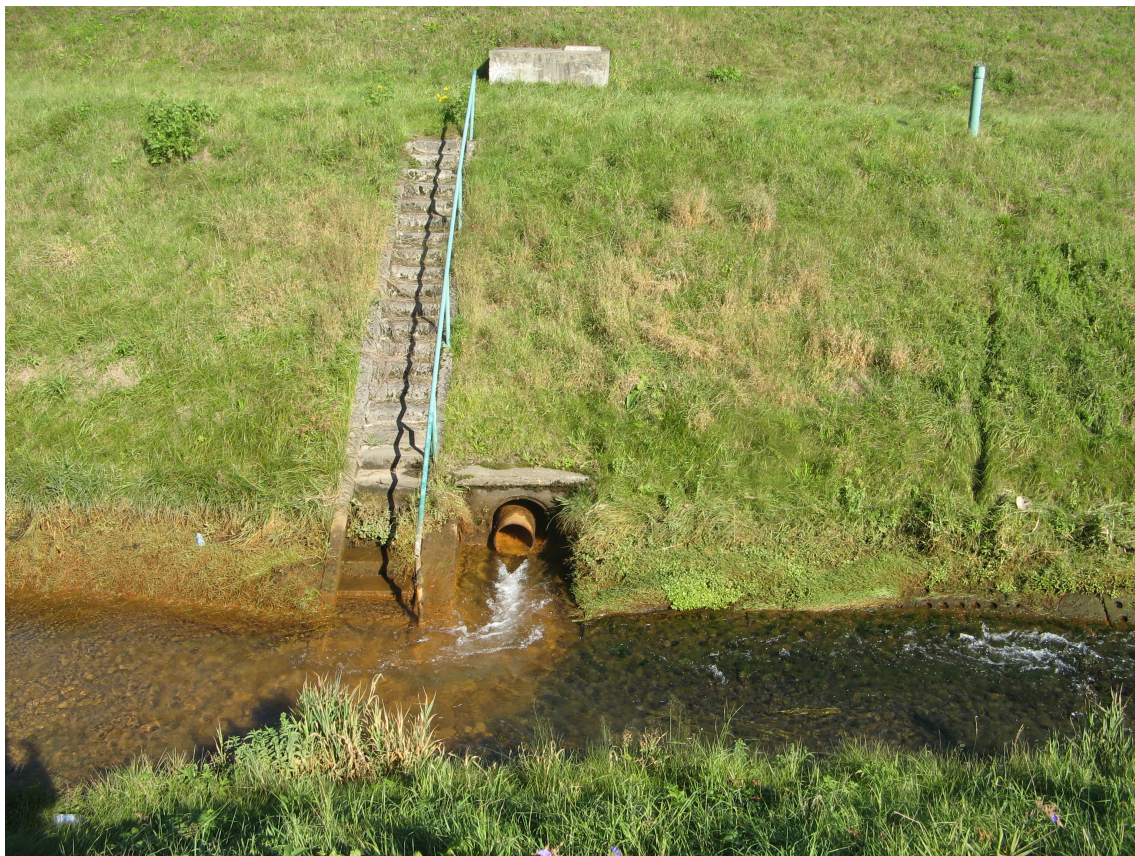
Fot.2 Widok na skarpe rowu przyzaporowego, studnię kontrolną i wylot z drenażu do rowu przyskarpowego i schody skarpowe.
