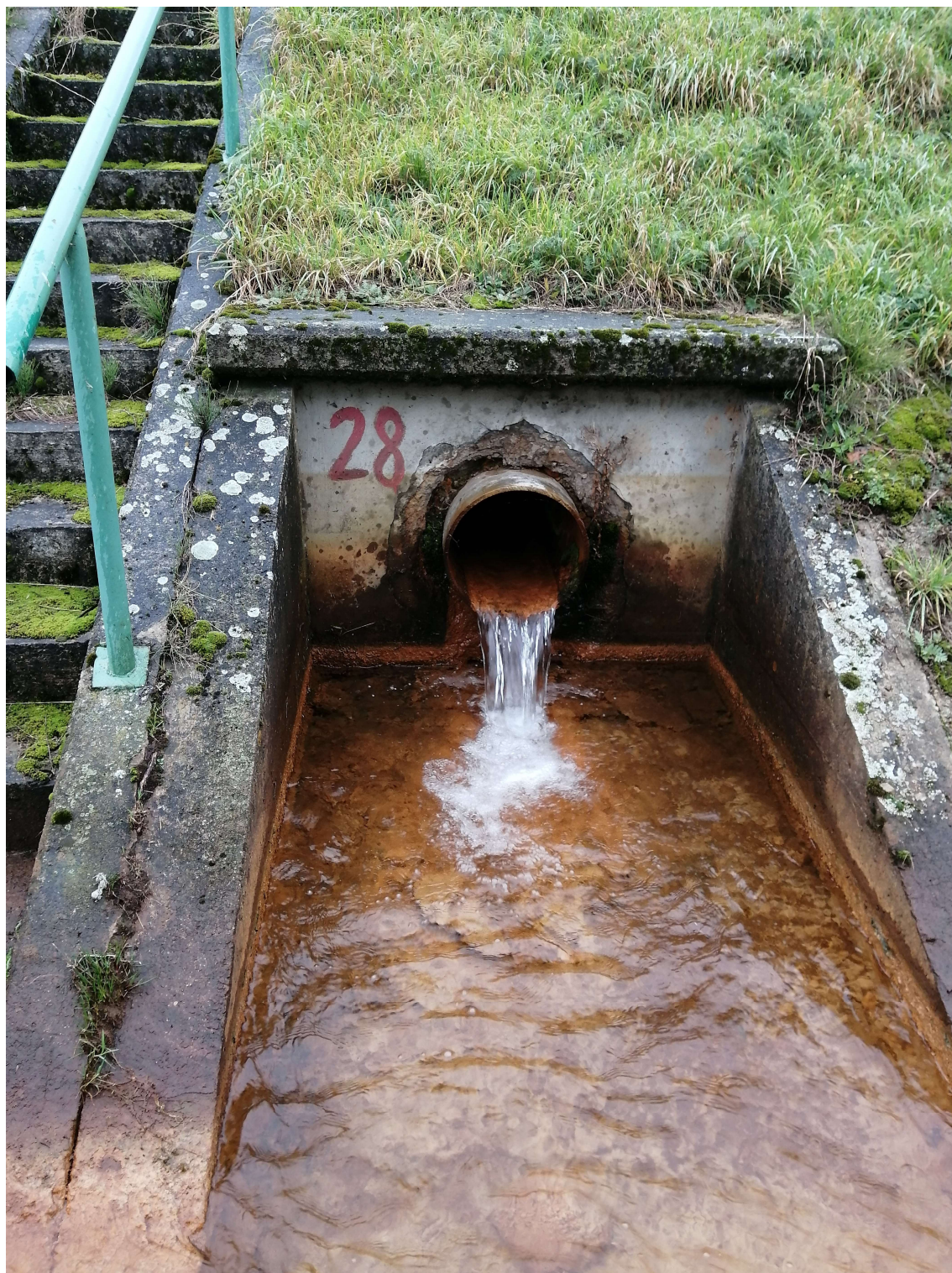
Fot.3 Widok na żelbetowy wylot z drenażu do rowu przyskarpowego.
