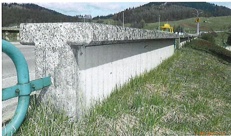
Fot . 7 Parapet zapory prawostronnej.
